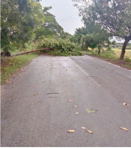
చిన్నకోడూరు-ఇల్లంతకుట రోడ్డుపై విరిగిపడిన హరితహారం చెట్లు
